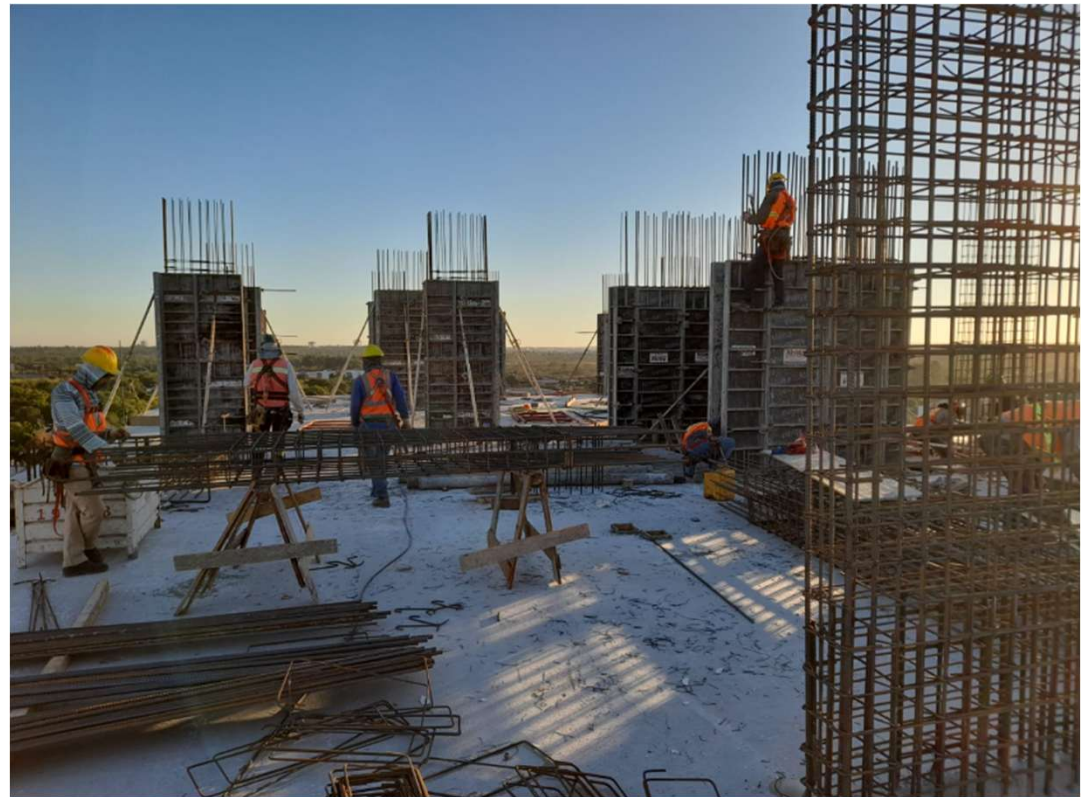
Cargamento de escalera N8-N9 – Cargamento de pilares N11-N12
