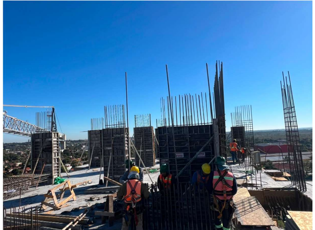
Cargamento de pilares N11-N12
